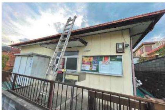
塗装工事前写真 玄関側
