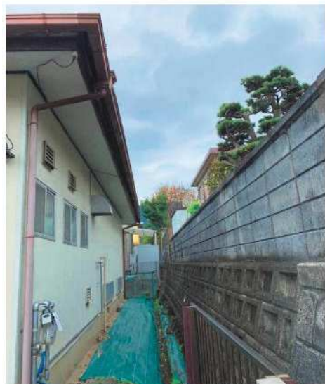
塗装前工事写真 北側
